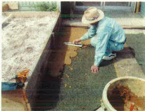
写真 9.多層式培養土システム施工状況
