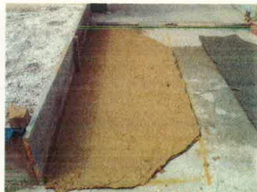
写真 9.多層式培養土システム施工状況
