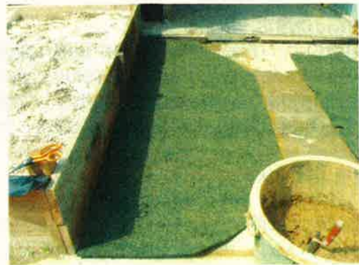
写真 8. 多層式培養土システム施工状況(その 1)
