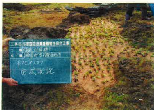
写真 4.施工終了状況
