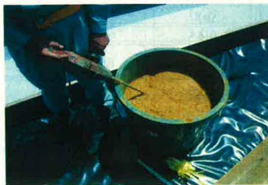
写真 1.ナルディ培養土攪拌状況
