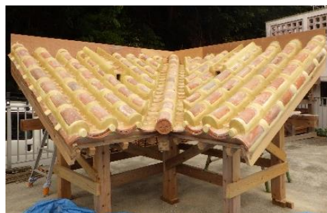
写真-4 赤瓦漆喰塗実習 製作架台
