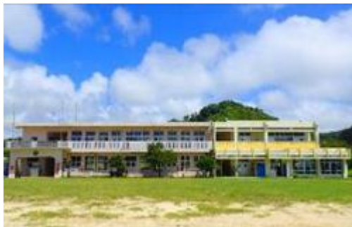
写真-1 美ら島自然学校（旧嘉陽小学校）全景
