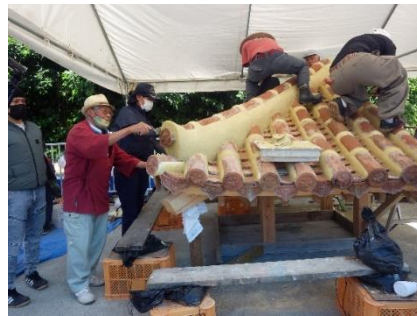
写真-4 赤瓦漆喰塗基礎 実習
