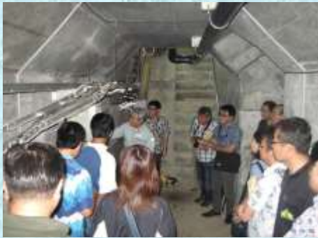
漢那ダム 監査廊内部
