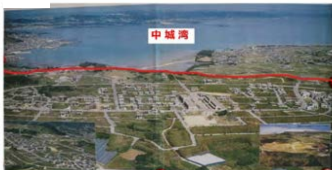
昭和61年に撮影された『つきしろ』の航空写真です。
